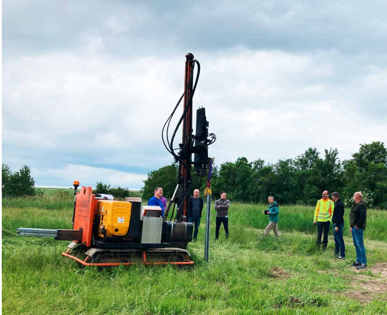
„Spatenstich“ für die neuen PV-Anlage, Mai 2024.
