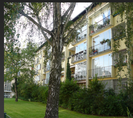
Moderne KWK-Technologie und Photovoltaik kommen in diesem Gebäude in Spandau zum Einsatz.
